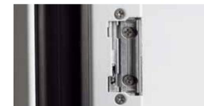
Beim **elektrischen Türöffner / ETOE** (Normalfunktion) ist die Tür nur während der Kontaktgabe (Taste gedrückt) zu öffnen (kein Dauerkontakt).
